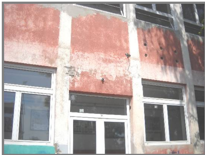
Slika 2.a. Izgled spoljašnjih zidova i stolarija objekta
